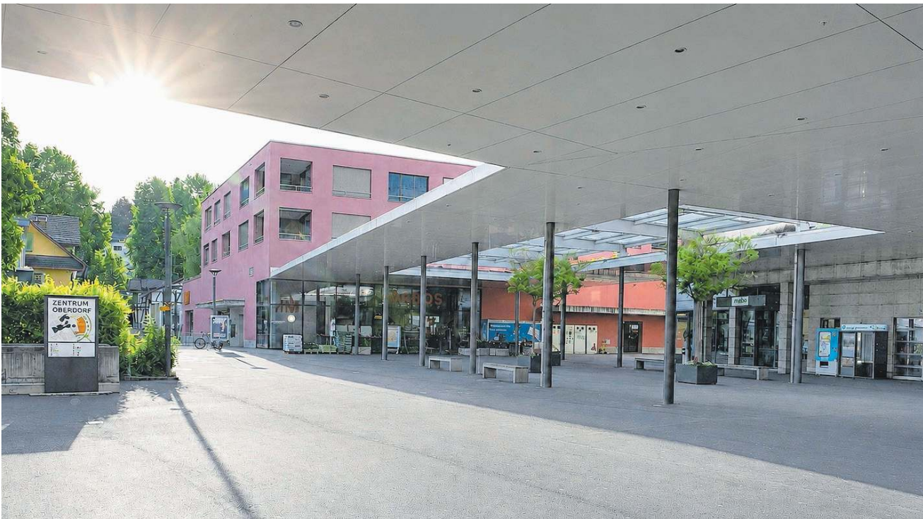
Der «hotteste» Hotspot im Amt: Das Stadtzentrum von Affoltern sollte noch etwas mehr begrünt werden, um übermässige Überwärmung zu vermeiden. (Bild Claudia Eugster)
