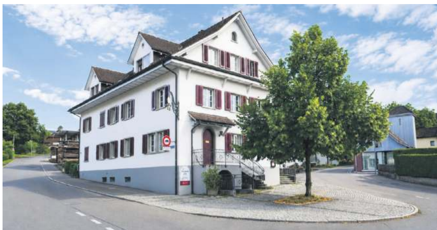
In Bonstetten im Dreieck Birchstrasse – Sagiweg – Aumülistrasse.
