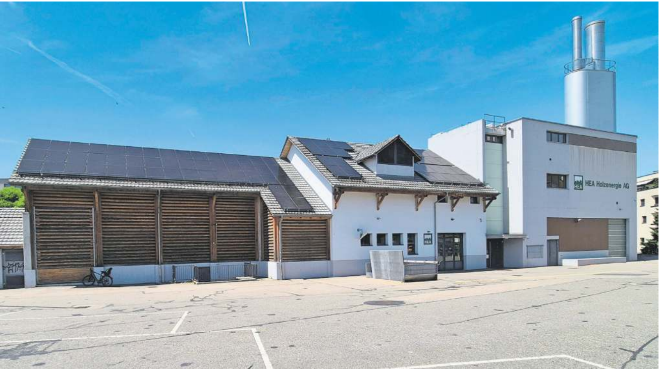
Die Fernwärmeanlagen – hier diejenige in Affoltern – werden künftig ausgebaut. Da die Region Knonauser Amt bereits Nettoimporteur von Holz ist, stehen dabei andere erneuerbare Energien im Vordergrund. (Bild Bernhard Schneider)
