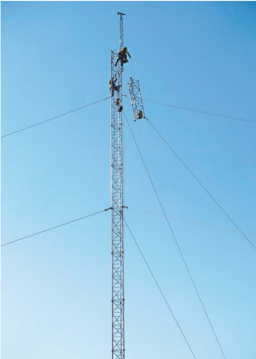
Das Errichten des Windmessmastes in Zünikon geschah mithilfe eines sogenannten Kletterkrans, der an der Spitze montiert war. (Bilder Marcus Weiss)
