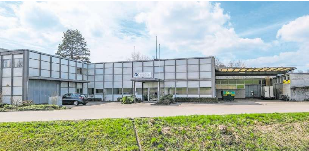
Das ist der neue Standort der Kradolfer AG in Wettswil. (Bild zvg)
