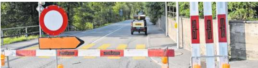
Umleitung: In Mettmenstetten wird der Bahnübergang gesperrt. (Symbolbild CH Media)
