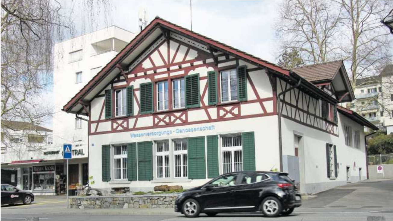
Das Gebäude der Wasserversorgungs-Genossenschaft Affoltern. Von dort werden auch die Aktivitäten der Gruppenwasserversorgung Amt organisiert. (Bild Florian Hofer)
